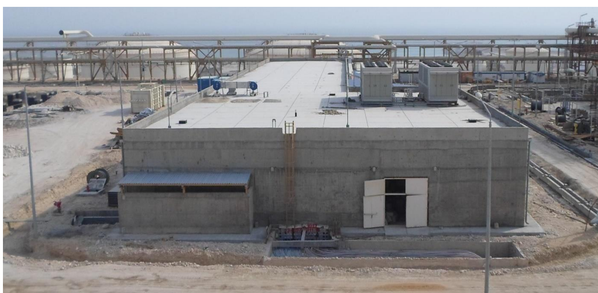
نمایی از وضعیت ساختمان های صنعتی (S۳۵, S۵۵) (الکتریکال و تابلوها)
