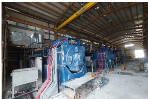
نمایی از سالن و ژنراتورهای نصب شده در نیروگاه ۳۰ مگاواتی (PGU)
