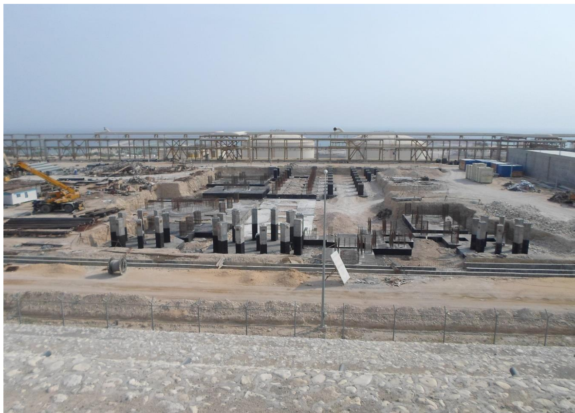
اجرای فونداسیون واحد گوگرد و نیتروژن زدایی نفتا (NHT)
