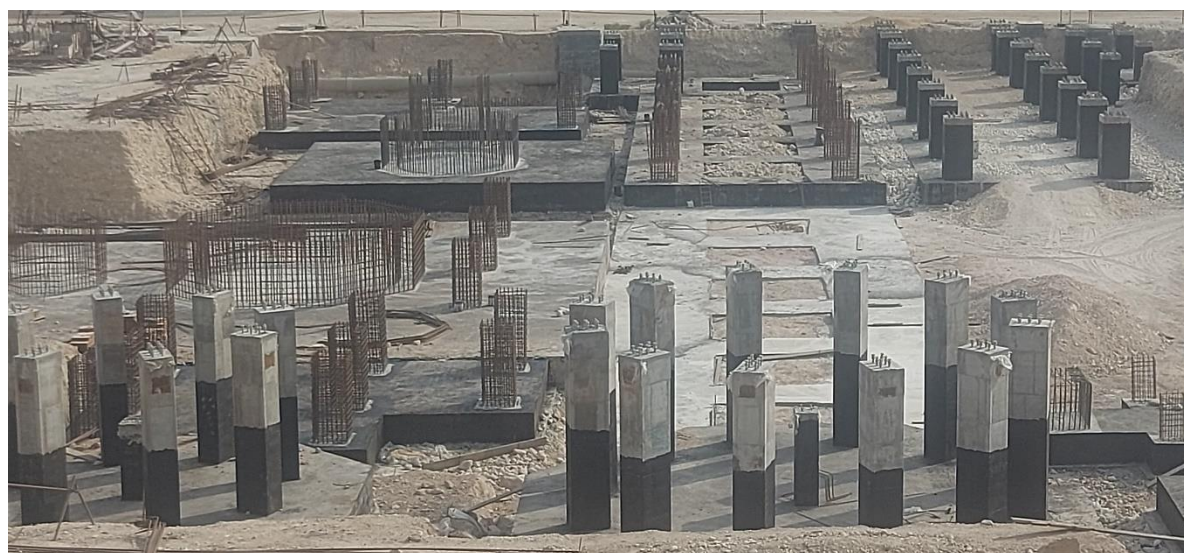
اجرای فونداسیون واحد گوگرد و نیتروژن زدایی نفتا (NHT)
