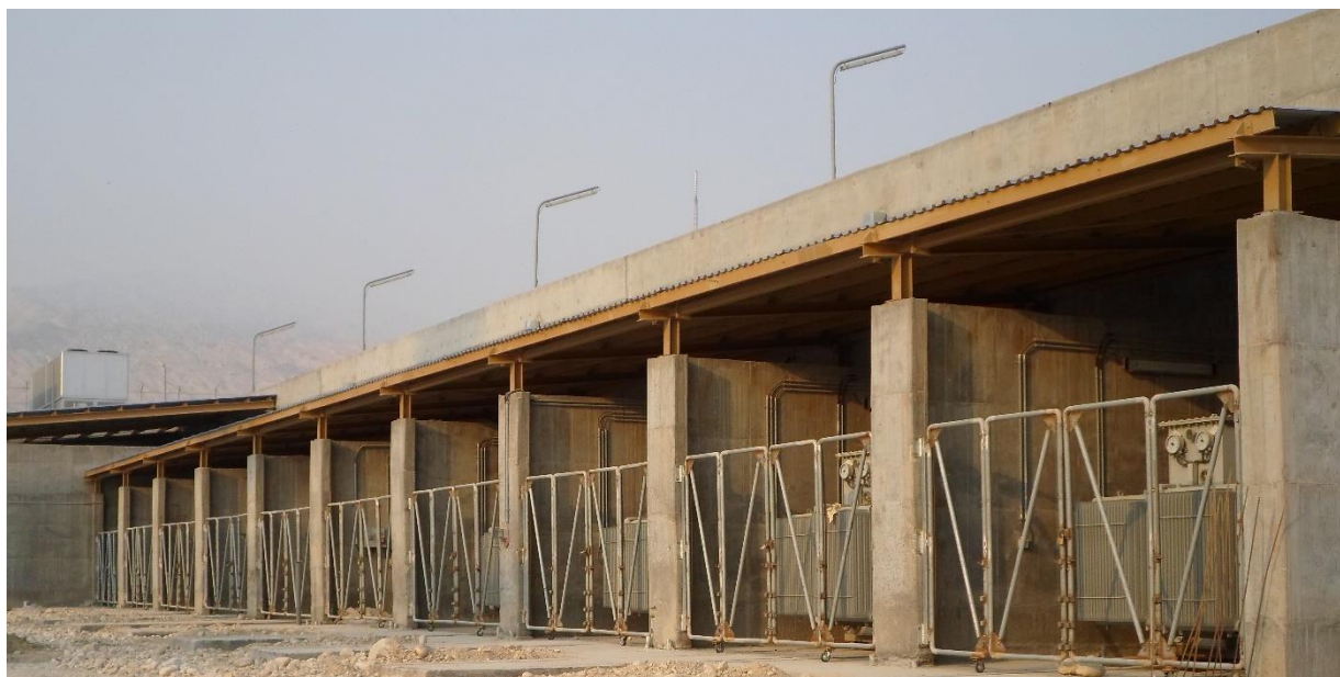
نمایی از وضعیت پست پاساژ (محل نصب ترانسفورماتورهای برق)
