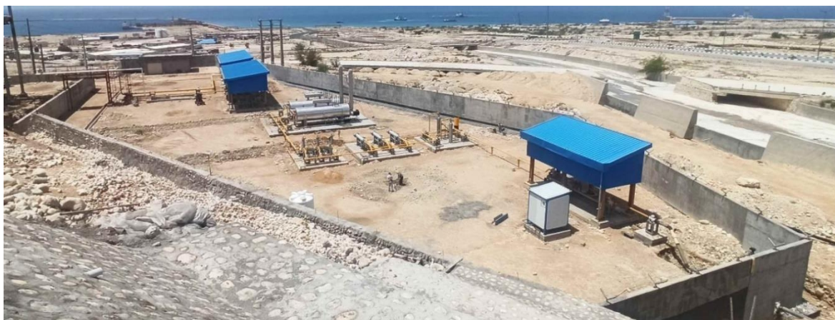
نمای کلی از واحد ایستگاه تقلیل فشار گاز
