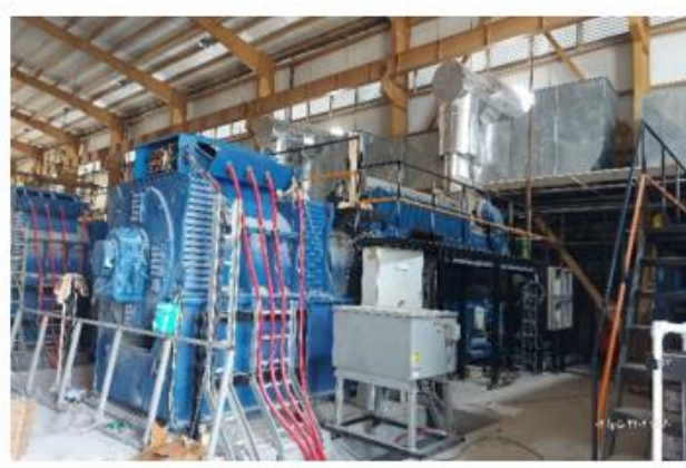
نمایی از سالن و ژنراتورهای نصب شده در نیروگاه ۳۰ مگاواتی (PGU)
