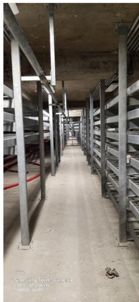
رکهای مربوط به کابل های برق و ترانس برق در محل پست پاساژ
